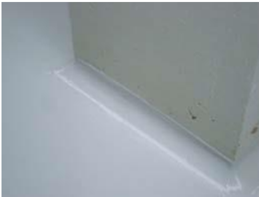
Fotos: Meia-cana com argamassa epóxi-silica
