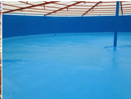
Fotos: reabilitação com POLYUREA RAYSTON ; na primeira fotografia vê-se perfeitamente a execução das meias-canas.
