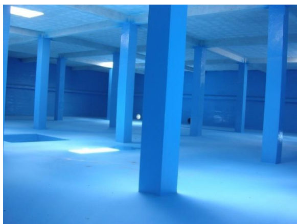
Foto: Tanque de água potável impermeabilizado com POLYUREA RAYSTON .
