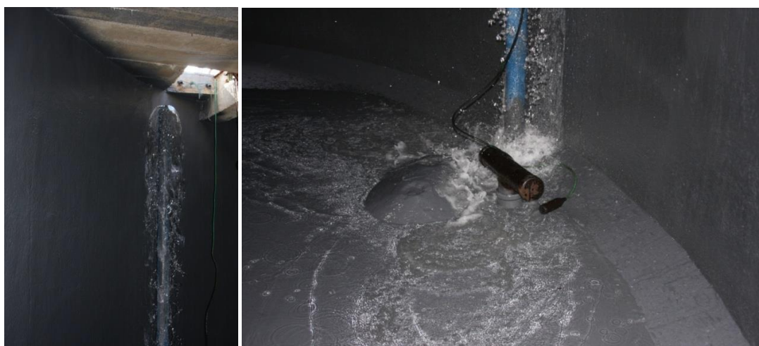
Foto: Enchimento de um tanque de água potável, após a sua impermeabilização com POLYUREA RAYSTON .
