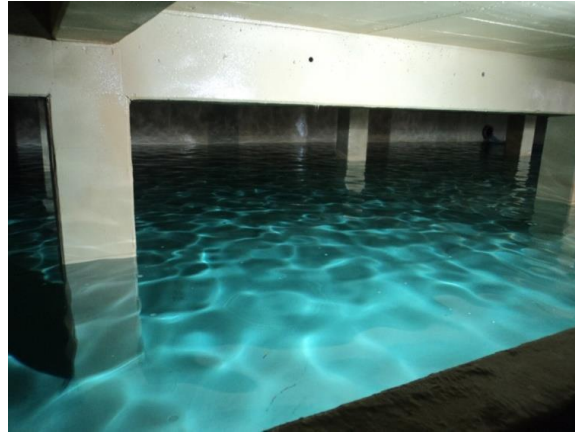
Foto: Tanque de água de processo, já em serviço, reabilitado com a projecção de POLYUREA RAYSTON , na fábrica da Seat em Martorell.
