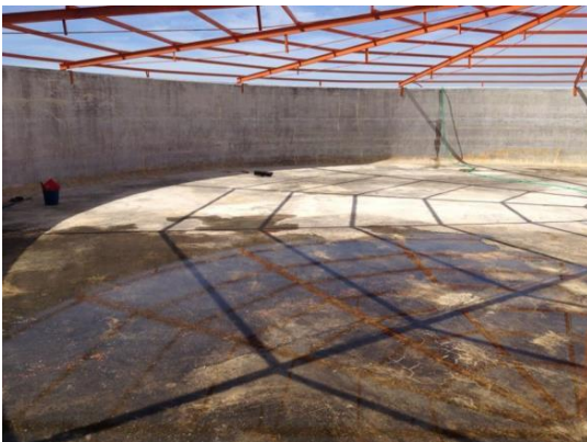
Fotos: reabilitação com POLYUREA RAYSTON ; na primeira fotografia vê-se perfeitamente a execução das meias-canas.
