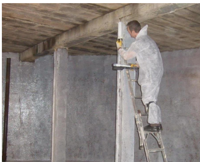
Foto: Aplicação do primário IMPRIMACIÓN H a rolo num depósito de água. A resina ao ser aplicada, apresenta um aspecto esbranquiçado, leitoso, que perde (ficando transparente) quando cura e a água que continha se evapora totalmente.
