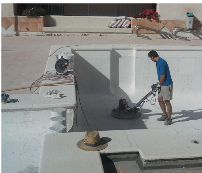
Foto: Tratamento da superfície de betão com uma máquina lixadora, de diamante, como parte da preparação do suporte, num processo de impermeabilização com POLYUREA RAYSTON .
